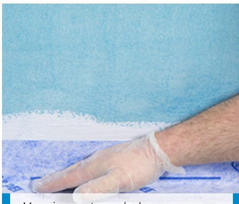
Mapei nurgatugevduskanga paigaldamine Mapegum WPS-i abil, põranda/seina üleminek
