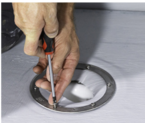
Äravoolutrapi paigaldamine, kasutades Mapegum WPS-i
