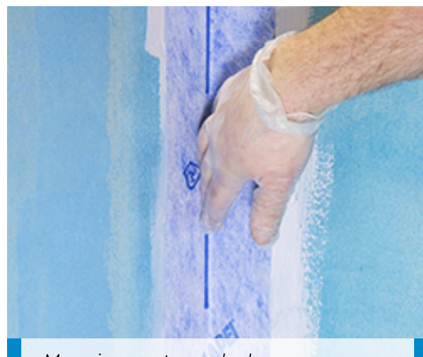
Mapei nurgatugevduskanga paigaldamine, kasutades Mapegum WPS-i
