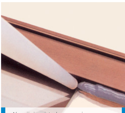
Alumiiniumist aknaraami tihendamine Mapesil AC-ga
